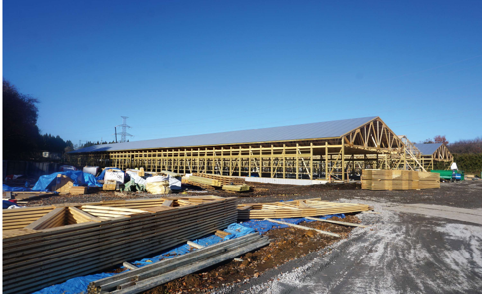
たかくらは、宮城県・古川で、約20億円弱の鶏舎建築を受注。一社完結型の施工体制の整備により、圧倒的な建築コスト削減を実現したことが、受注の決め手になった
