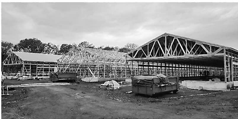
1万5,000坪の敷地に約300坪の鶏舎12棟を建設する
