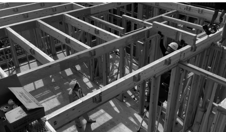
ユニオンフレームの施工現場。4×6材を床の構成部材などとして有効に配置して使用することで、躯体の合理化を図れる
