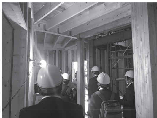
写真 1 2 × 4 工法一般床 根太 2 × 10 @ 455mm (筆者撮影)
