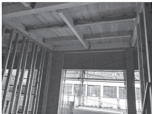
写真 2 Union Frame® 床組 梁 406、410 @ 910mm (筆者撮影)
