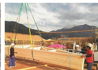
工事中の様子。工期短縮のため3区に分けて施工した。さらに、トラス工法を採用したことで工期短縮・コスト削減につながった。
