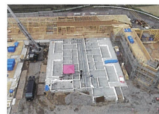
工事中の様子。工期短縮のため3区に分けて施工した。さらに、トラス工法を採用したことで工期短縮・コスト削減につながった。
