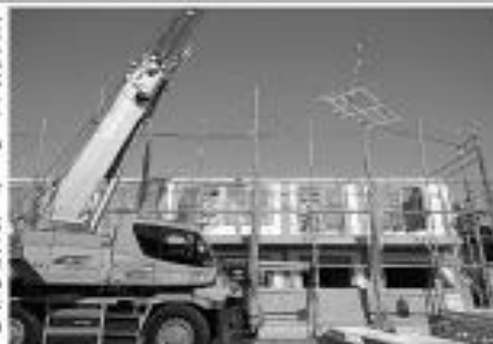
建て方白川、2階の壁まで組み上げた現場
