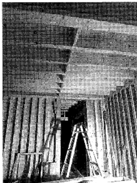
ビルの内部。工法は一般的な2×4だ
