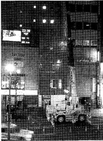
繁華街の狭小地に建設されるため、夜間工事で資材搬入などが行われる
