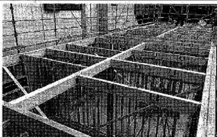
ユニオン・フレームの床組み
